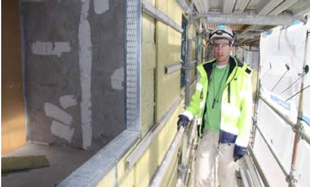
Yttervägg i Brogården Alingsås (Foto: www.sbi.se)
